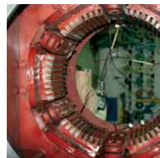
Neuwicklung eines 750 kw Gleichstromstator
